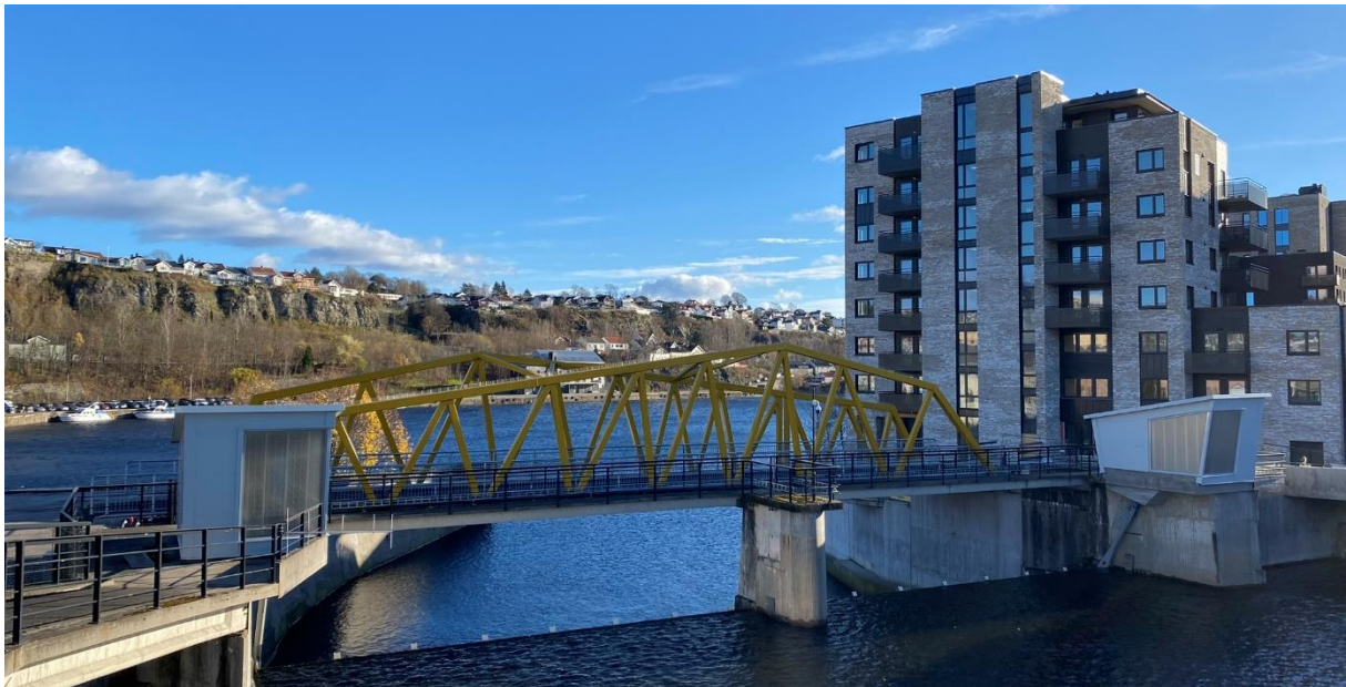
Figur 2: Den nye gang- og sykkelbrua over Damfossen ble ferdig høsten 2024
