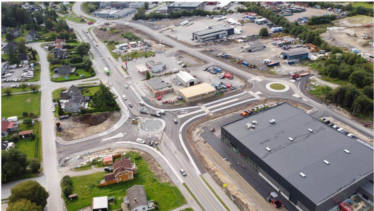
Fv. 32 Vallermyrvegen - Ullinvegen (Enger), nytt kryss og gang- og sykkelveg er det største prosjektet som er realisert i 2023
