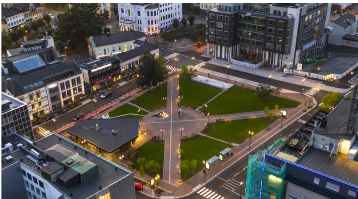
Figur 4: Ny park og kollektivterminal på Landmannstorget i Skien åpnet i 2020. Prosjektet gjør det attraktivt å oppholde seg i sentrum, styrker kollektivtilbudet og bidrar til privat investeringslyst. Øverst til høyre i bildekant ses det nye fylkeshuset. (Foto: Per-Åge Eriksen)
