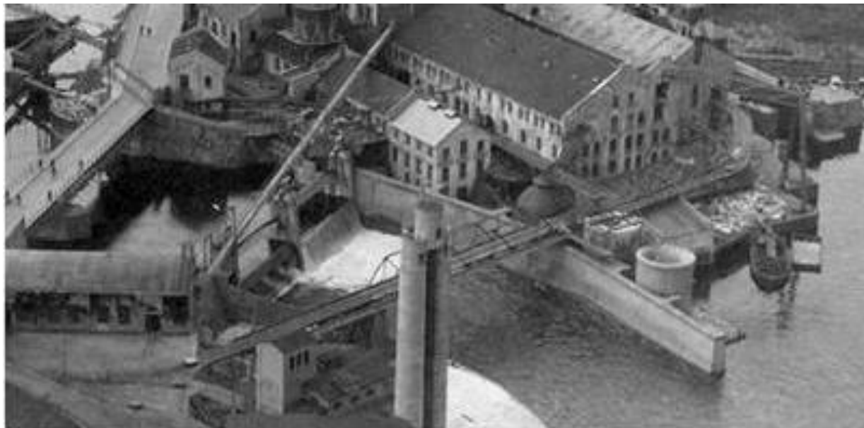
Bilde 12: Ny bru skal bygges over Damfoss og vil forbinde Klosterøya og Smieøya på nedre nivå
