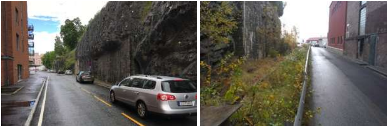
Bilde 10: Bak hotellet på Langbrygga er kjørebanelen utvidet og åpner for etablering av miljøgata på framsiden ut mot Bryggevatnet (før og etter)
