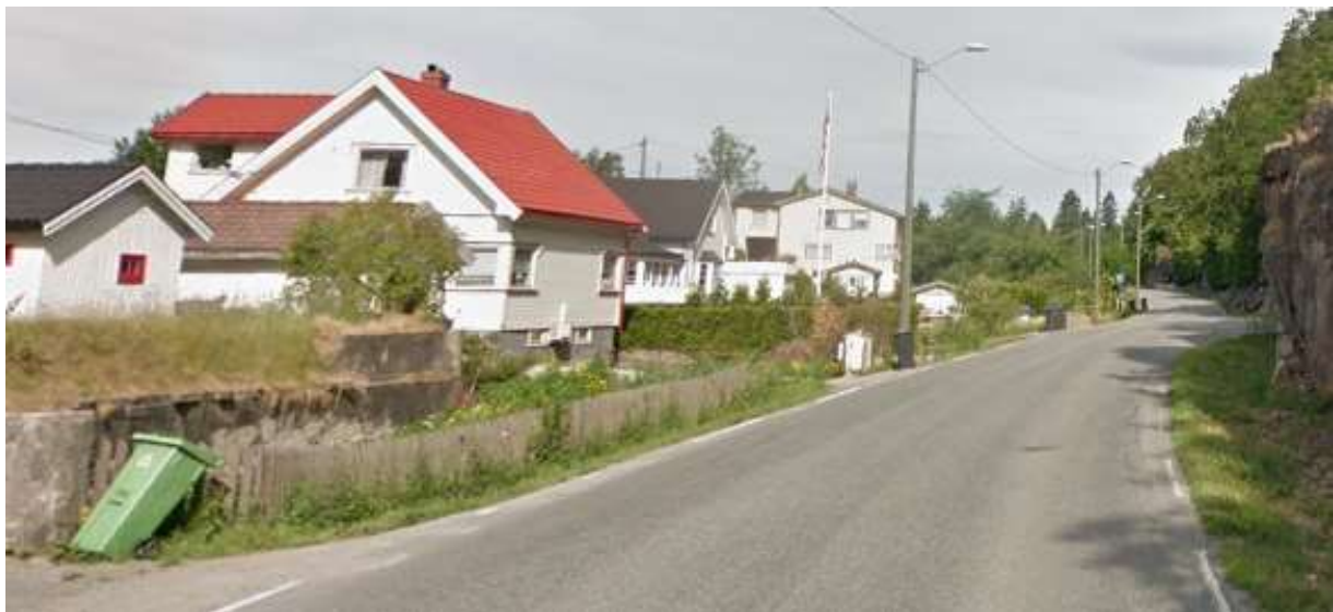
Bilde 15: På denne strekningen ved Grøtsund skal det etableres fortau eller gang- og sykkelveg
