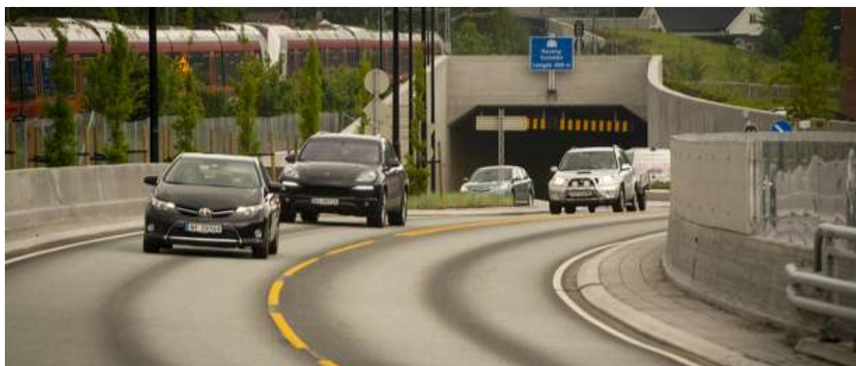
Bilde 3: Åpning av ny Fv.32 gjennom Porsgrunn sentrum har gitt mange en bedre hverdag
