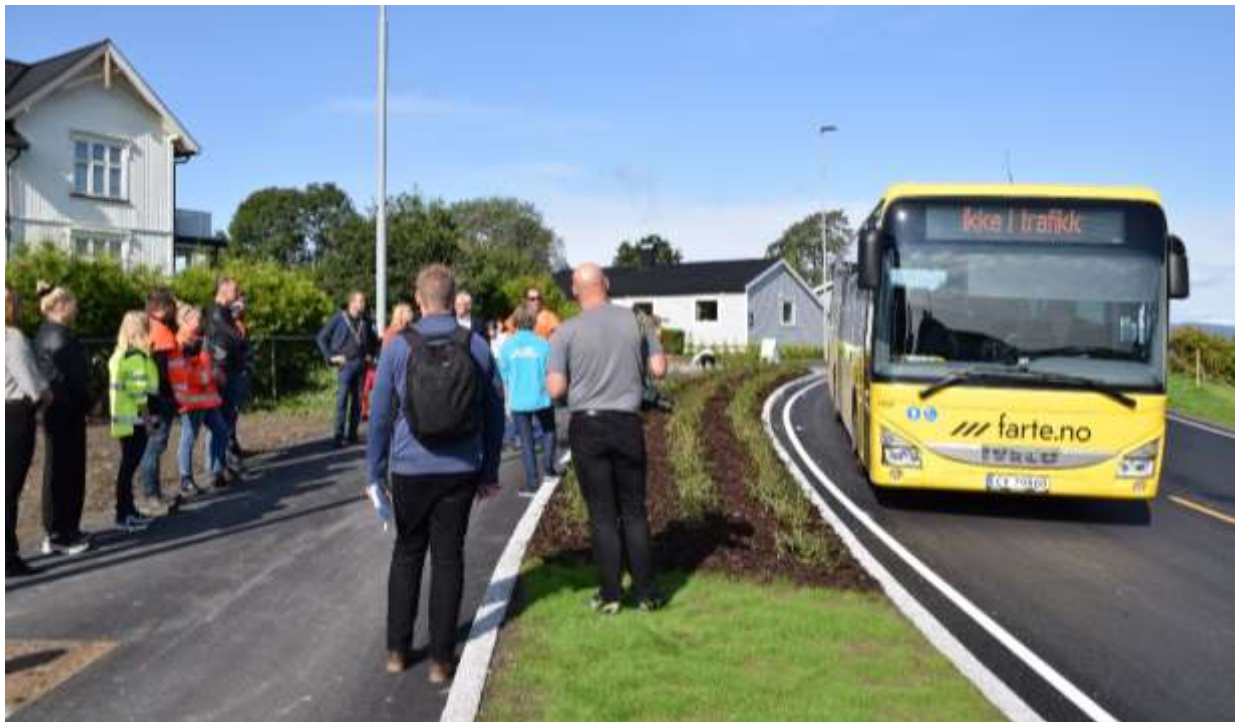
Bilde 2: Ny fylkesveg fra Pettersborg til Skien stasjon skaper trygghet både for lokalbefolkning og næringsliv
