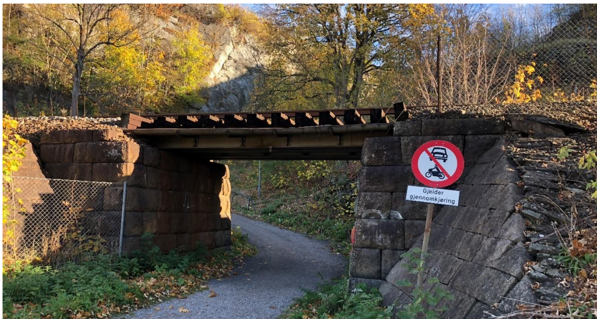
Figur 30: Eldre bro og gangveg ved Follestad. Det er forutsatt i alternativ 2 at broen må erstattes av en ny (Foto: Sweco).
