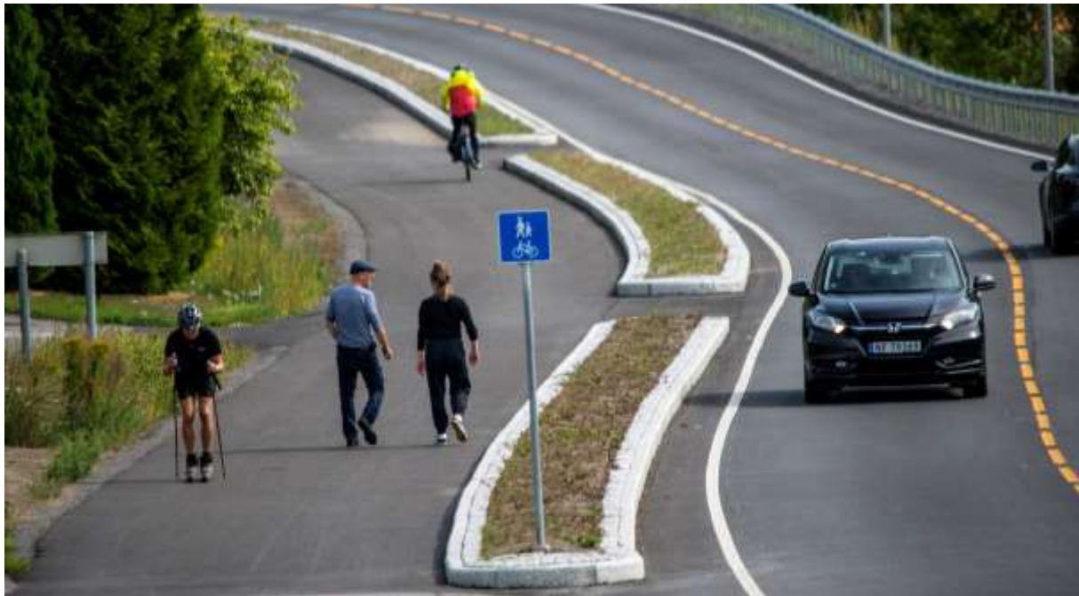
Bilde 18: Ny gang- og sykkelveg på Nystrand stod ferdig i 2018.
