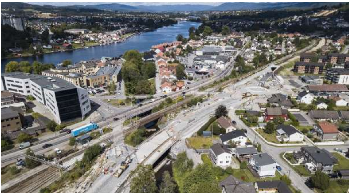
Bilde 1: Lilleelvprosjektet nærmer seg ferdigstilling. Åpnes for trafikk i løpet av 2018.
