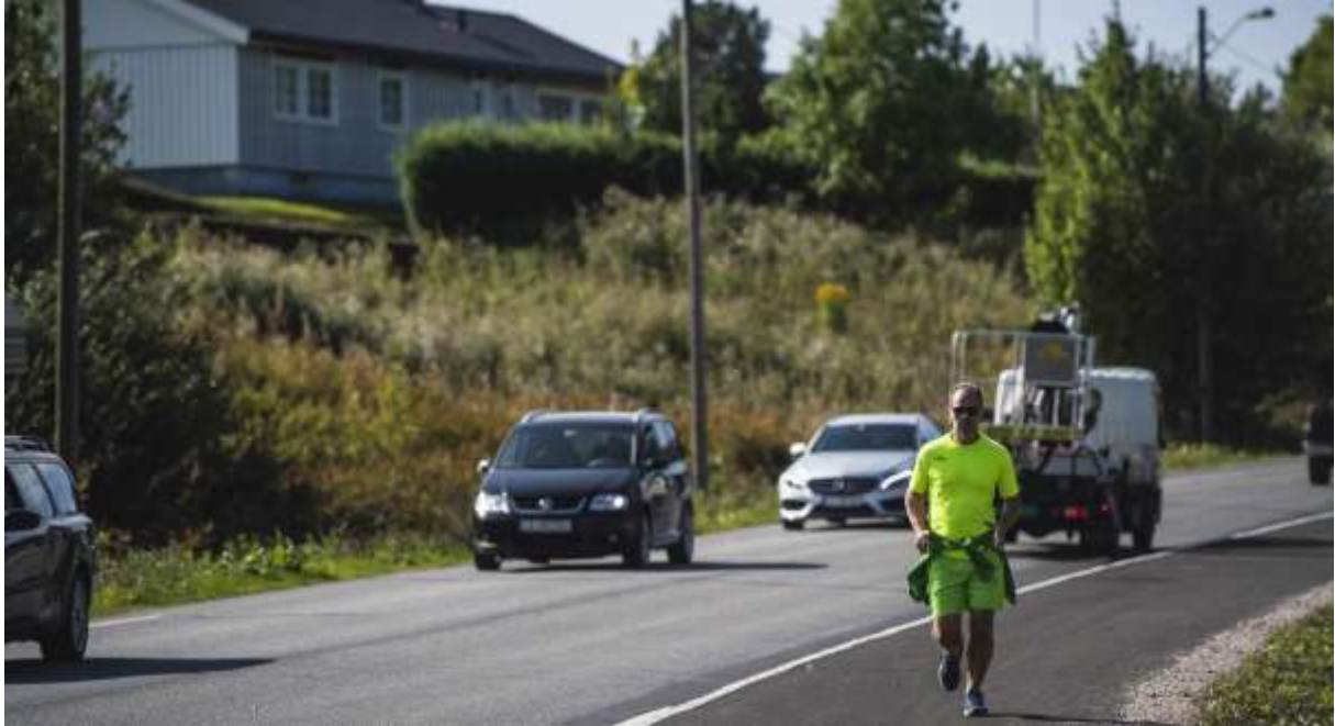
Bilde 17: Bypakka har bygget nytt fortau i Klyvevegen i 2018.
