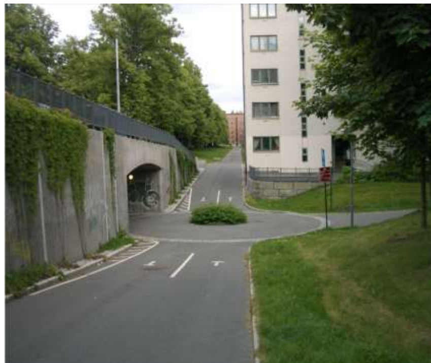
Figur 20 Chr. Michelsens gate, Oslo. Bred undergang med rundkjøring og adskilte kjøreretninger for syklistene. I selve undergangen er arealet for fotgjengere og syklistene adskilt. Foto: Finn Aslaksen, Vista Utredning as.
