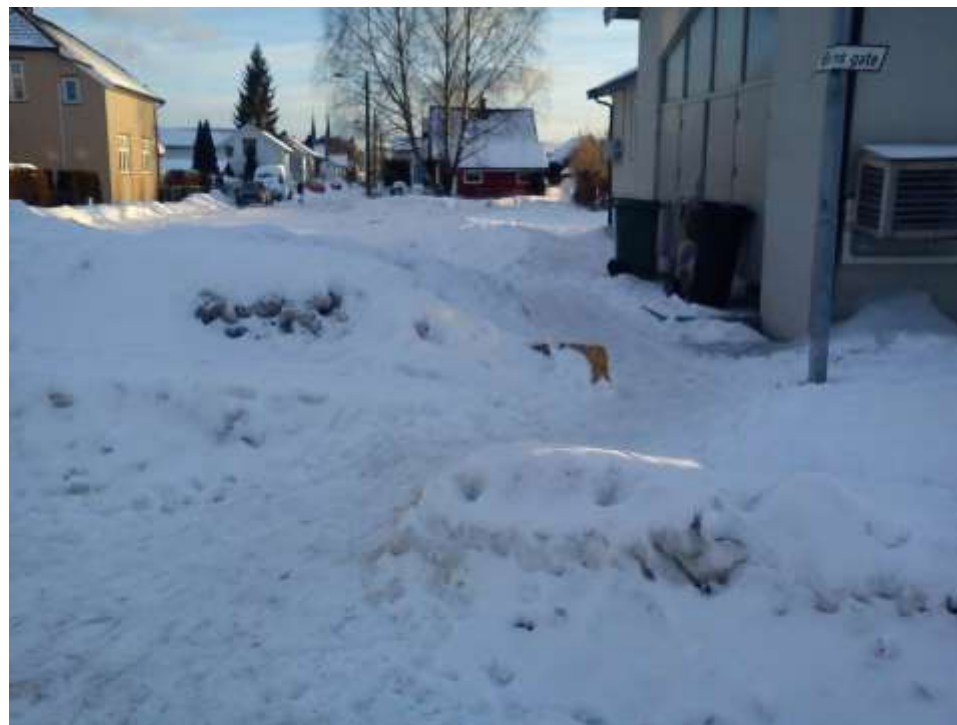
Figur 25 Bildet viser krysset Chr. Bloms gate/lvar Aasens gate i Skien vinter 2013. Vegen er stengt for gjennomkjøring med fastasfalterte betonggriser i hele bredden. Det er dårlig framkommelighet for myke trafikanter hele året, men spesielt vanskelig om vinteren med stort snøopplag og ingen gjennombryting.
