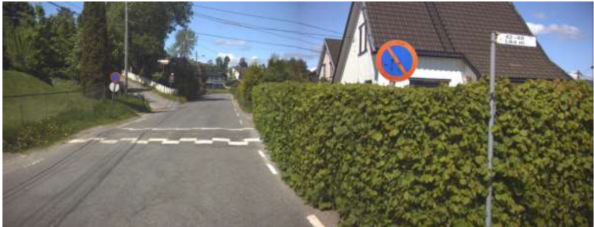
Bilde: 13 I Gulsetveien har myke trafikanter trange kår. I 2019 starter arbeidet med å etablere fortau på venstre side.
