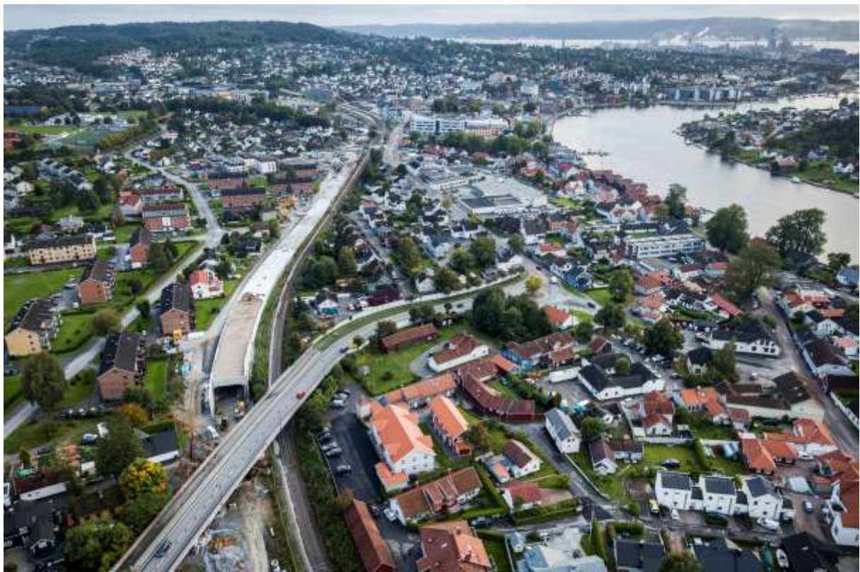
Bilde: 3 Fv. 32 Gimleveggen – Augestadveggen «Lilleelvaprojektet» er bypakkas største prosjekt. Nye veg- og sykkeløstninger gjennom Porsgrunn sentrum vil stå ferdig sommeren 2018. Foto: Dag Jensen
