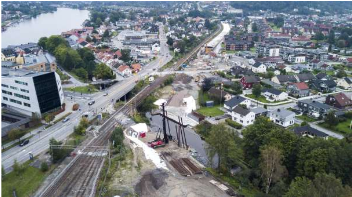
Bilde: 12 Lilleelvprosjektet er Bypakke Grenlands største prosjekt som står ferdig sommeren 2018
