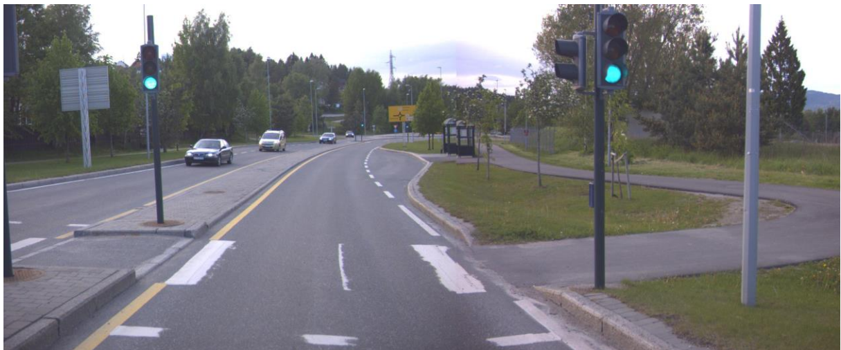
Bilde: Moflata området er en utfordring. Tiltak for å bedre fremkommelighet for kollektivtrafikk og næringstrafikk er vurdert.
